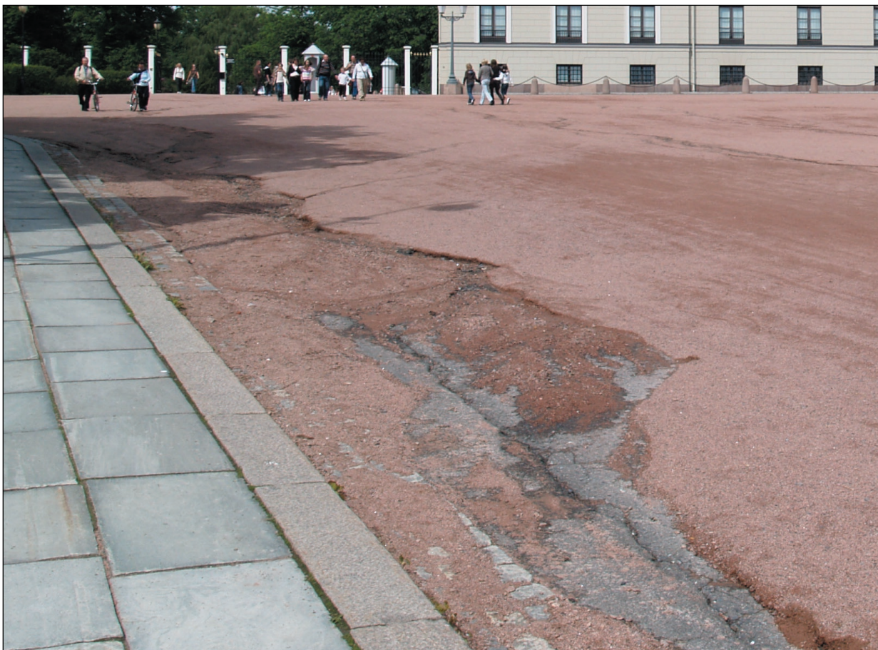
Bilde 4: Slitasje etter store nedbørsmengder
