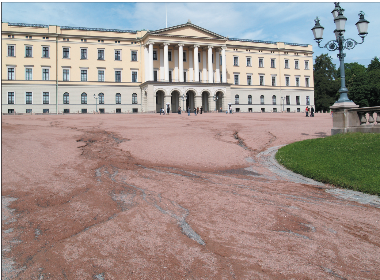
Bilde 3: Slitasje på Slottsplassen på grunn av ikke tilfredsstillende dekke, 2007
